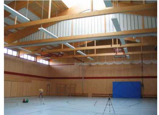
Raum- und bauakustisch sanierte Dreifeldsporthalle.
