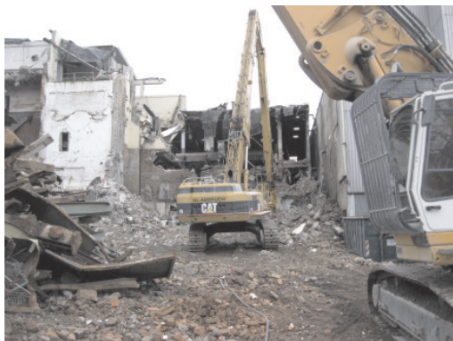
Anregung aus Baubetrieb: Abrissarbeiten
